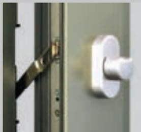
Sperrbügelschloss mit Drehknopf aus Edelstahl
